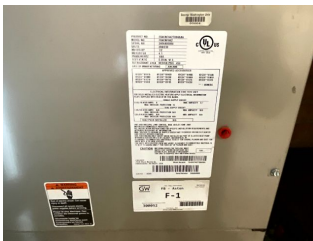
Fan Coil Unit - DX Cooling - 3.5 Ton
